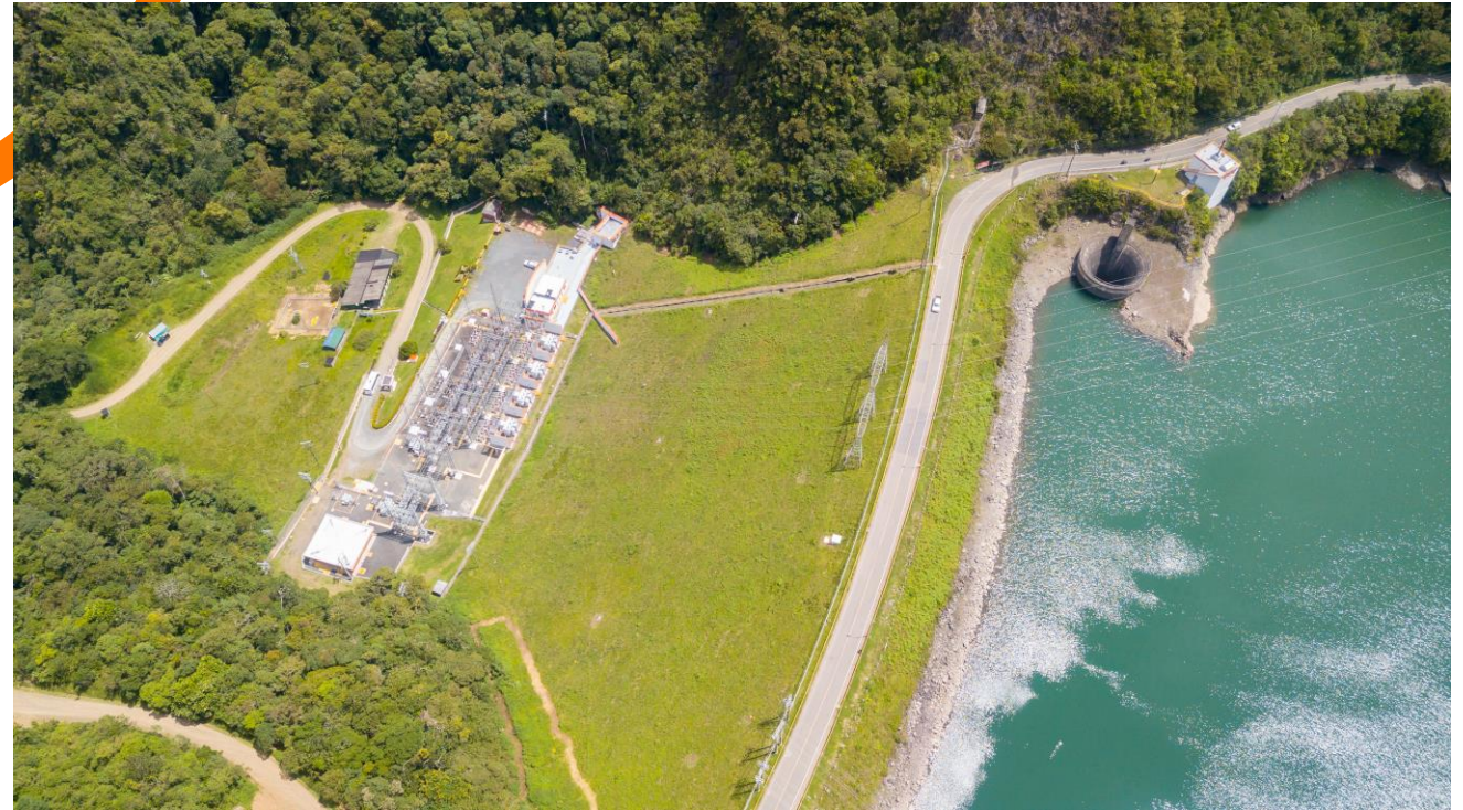
Central Hidroeléctrica Calma Calima, Valle del Cauca
