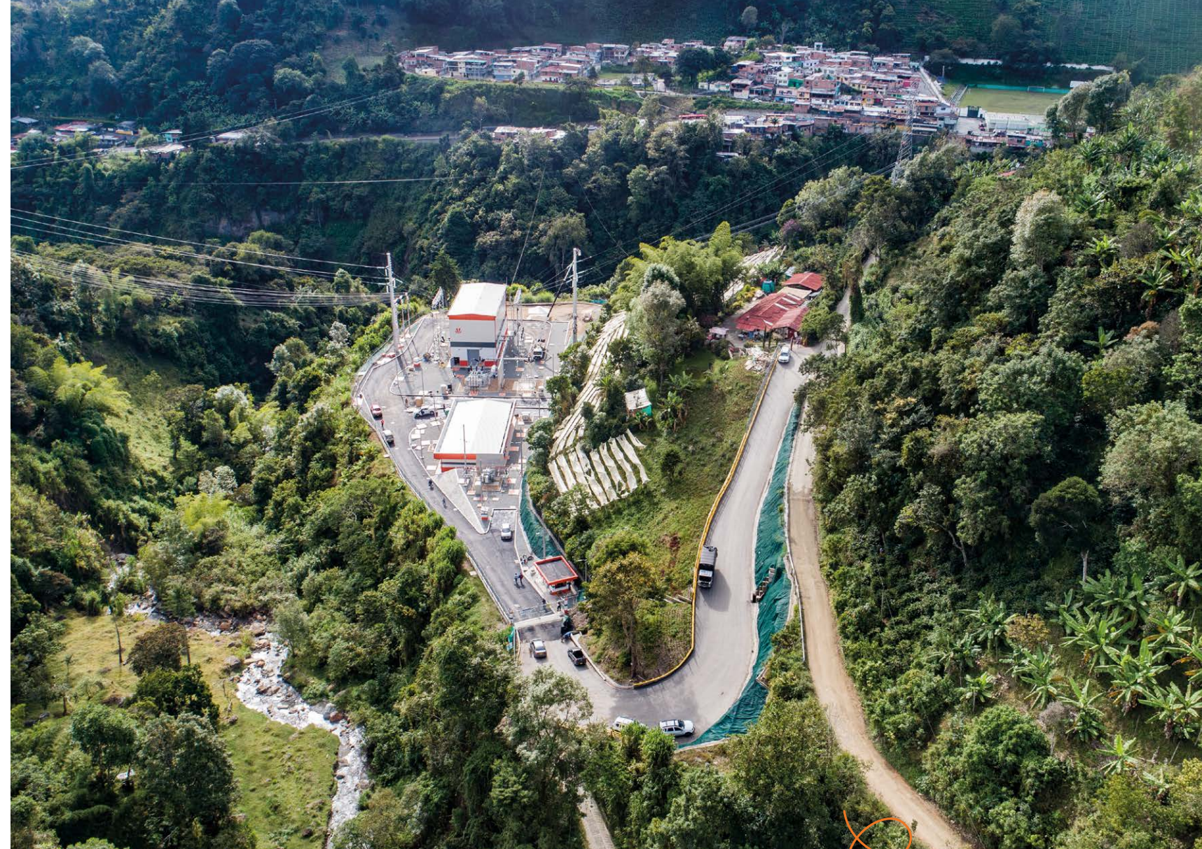
Subestación Cajamarca (Tolima), la primera digital del departamento.
